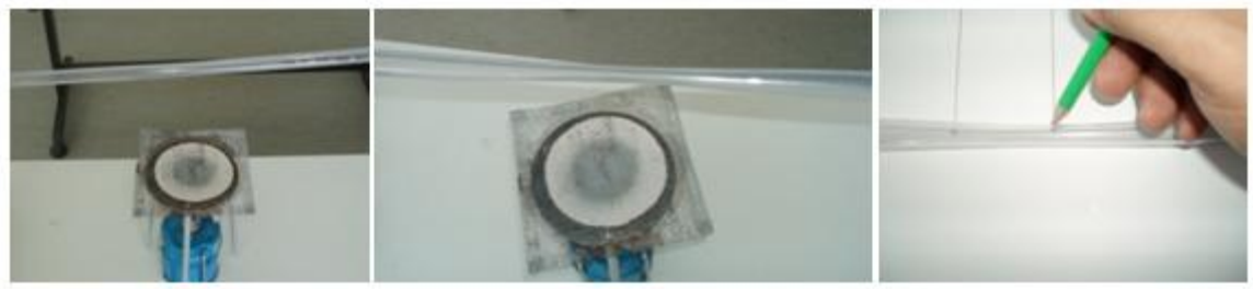
Εικόνα 2. (α) και (β) μορφοποιώντας το αλφαδολάστιχο. (γ) μαρκάροντας το σωλήνα.
